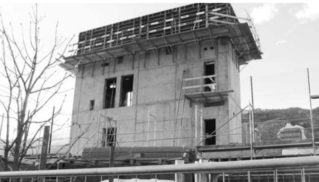
Treppenhaus wartet auf Holz
