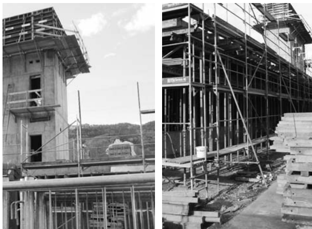
Start mit Beton im Erdgeschoss
