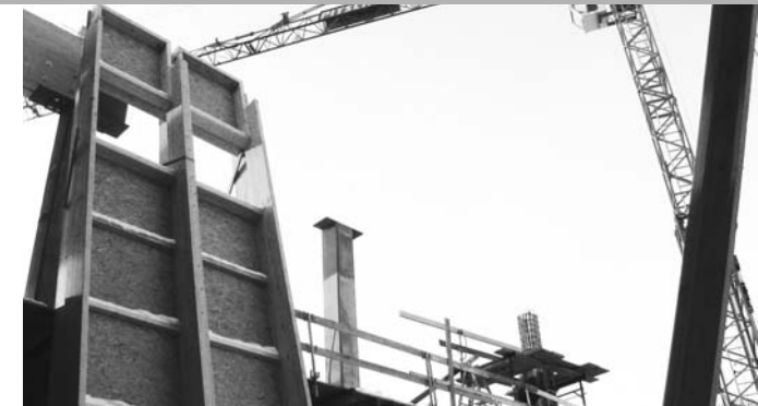
Holzelemente und Ortsbeton
